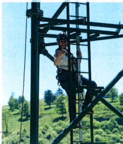
Pose du pylône de téléphonie mobile à Albé
